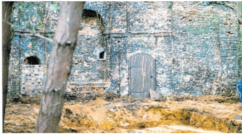
Die beschädigte Mauer des Brunnens wurde denkmalgerecht wieder instand gesetzt.
